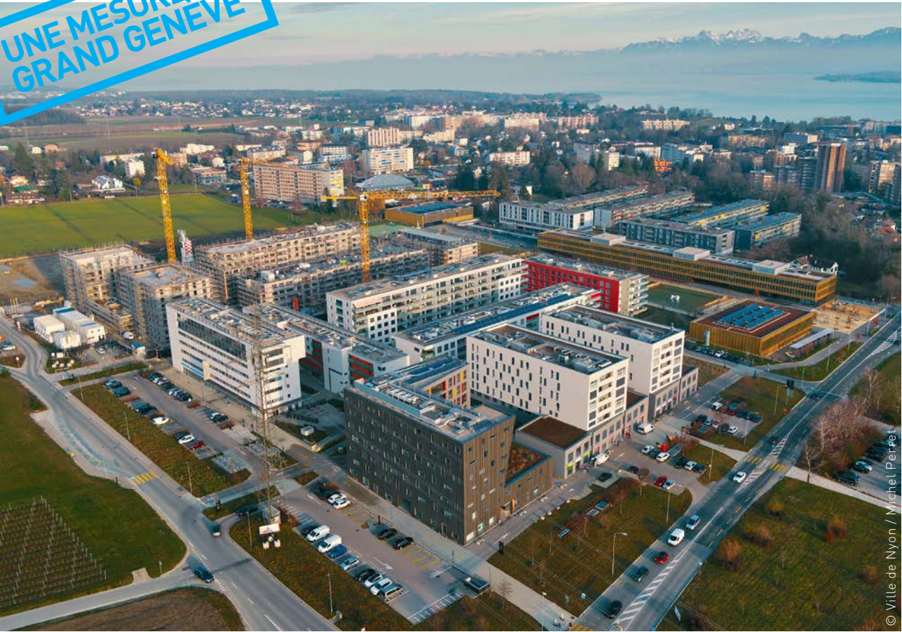
Ecoquartier de la Petite prairie à Nyon.
