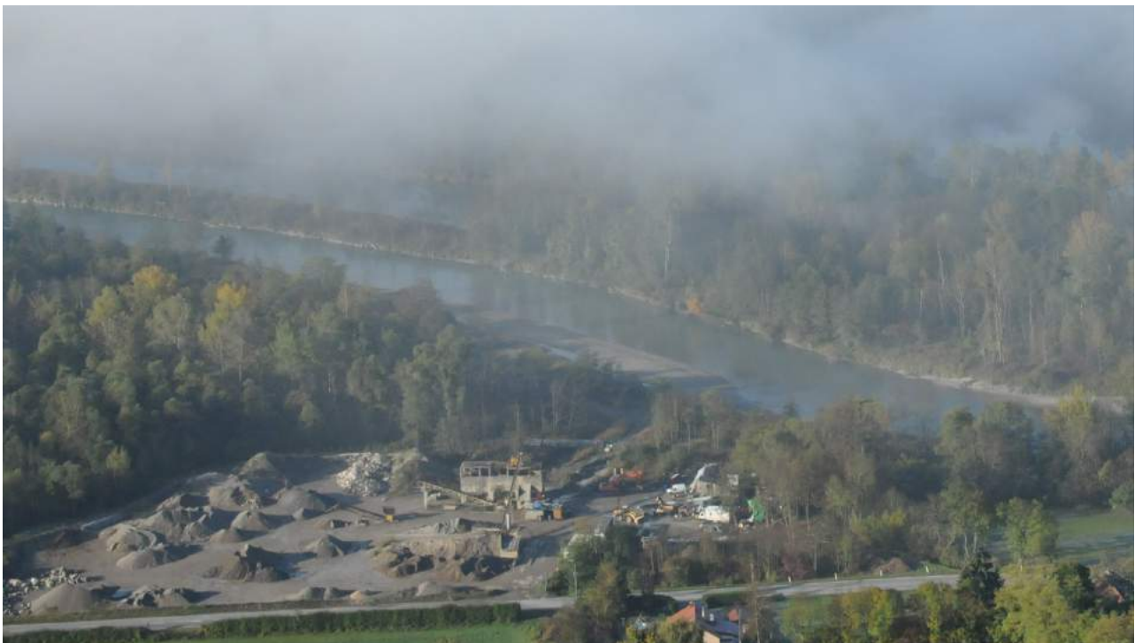
Fig.11 Dépôt de matériaux dans une ancienne gravière au bord de l'Arve
