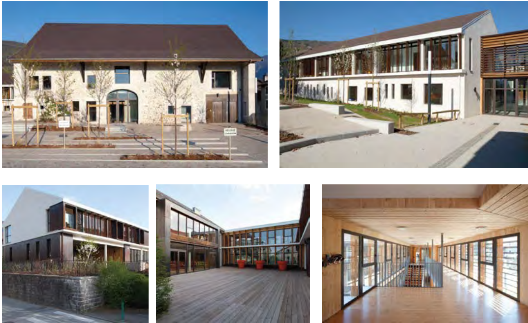
Exemple d'ensemble requalifié mettant en valeur le patrimoine bâti : restauration et aménagement d'une ancienne ferme en groupe scolaire Photographie CAUE 74 / Catherine BOIDEVAIX Architecte (2012)
