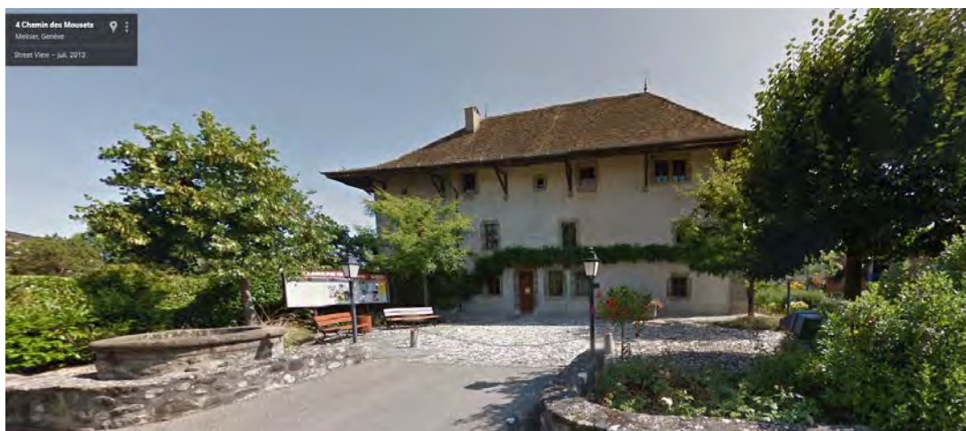
Exemple d'ensemble requalifié mettant en valeur le patrimoine bâti : maison forte et dépendances agricoles des XV e -XVI e siècles restaurées et transformées en mairie en 1984 (chef-lieu) Photographies Google car (2013)
