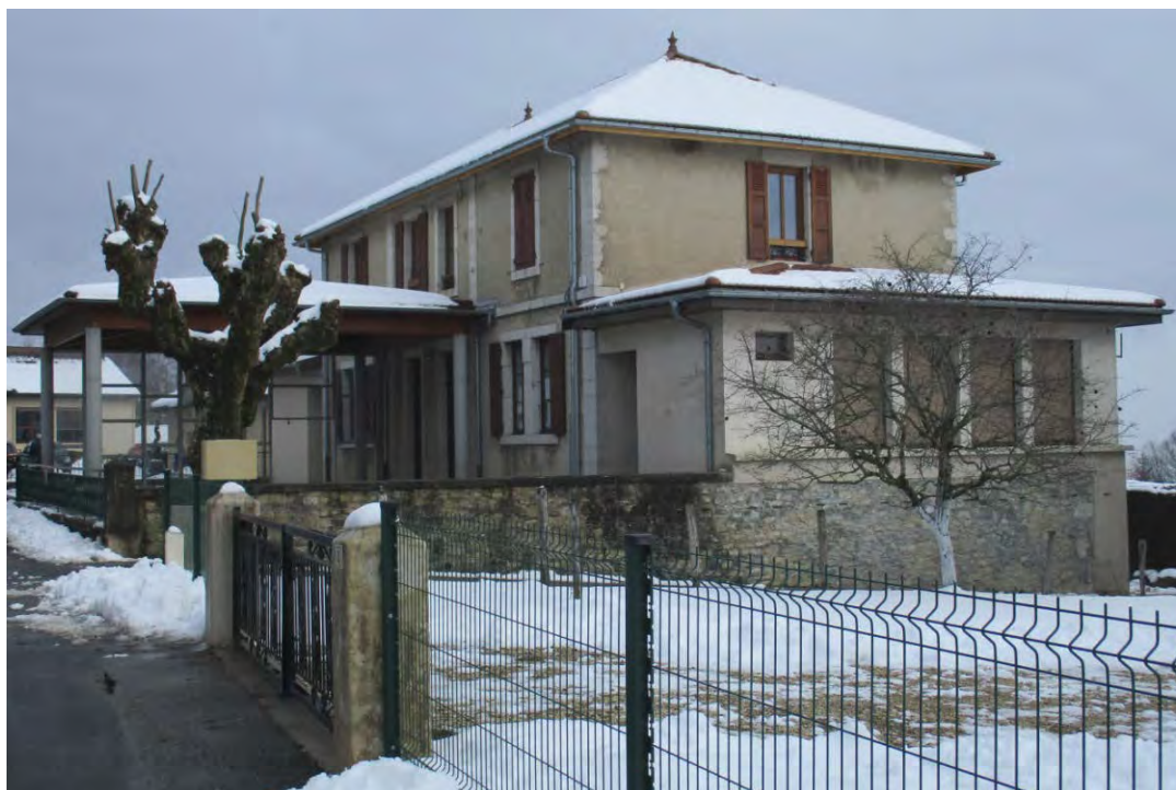
Exemple de construction nouvelle s'insérant dans le paysage bâti : préau contemporain ajouté sur la façade de l'école Lorelei JAUNIN (2016)
