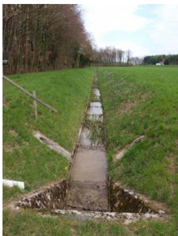
Le Creuson, une rivière canalisée vers le bois des Portes. Une renaturation est en cours.
