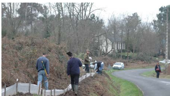
Installation d'un crapauduc temporaire sur la commune de Rou-Marson (Maine et Loire)
