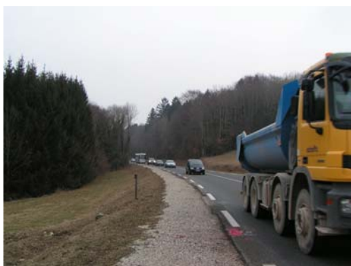
La route D984 entre Gex et Divonne, accidentogène pour la grande faune.
