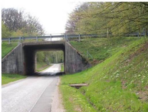
L'un des passages utilisés par la faune pour traverser l'autoroute.
