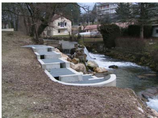
Exemple de passe à poissons déjà installée sur la Versoix (commune de Divonne les Bains)
