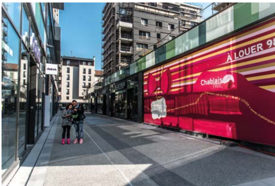
Chablais Parc, Annemasse
