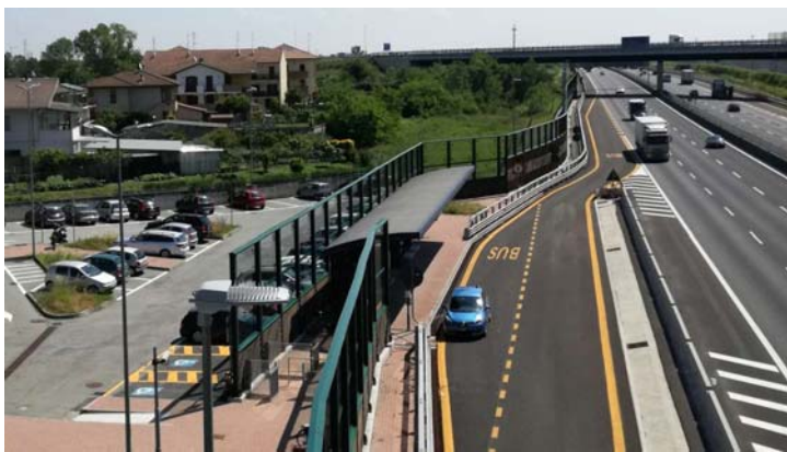
Figure 72 : Exemple d'arrêt de bus car express Marseille - Aix-en-Provence
