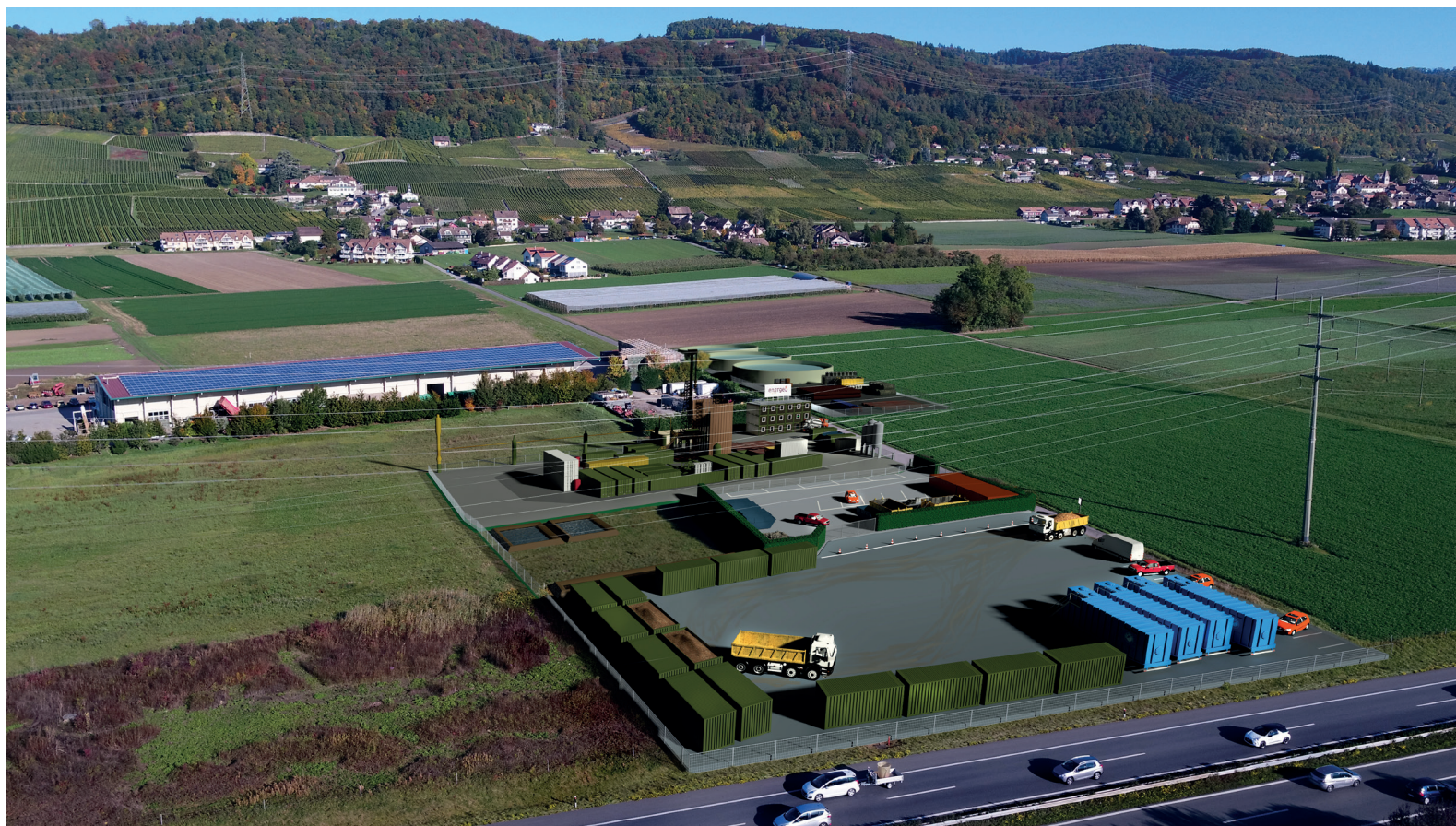
Projet de moyenne profondeur EnergieÖ à Vinzel : phase d'exploration © EnergieÖ
