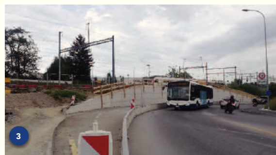
^Travaux de renforcement / nouvel accès ?(3)
