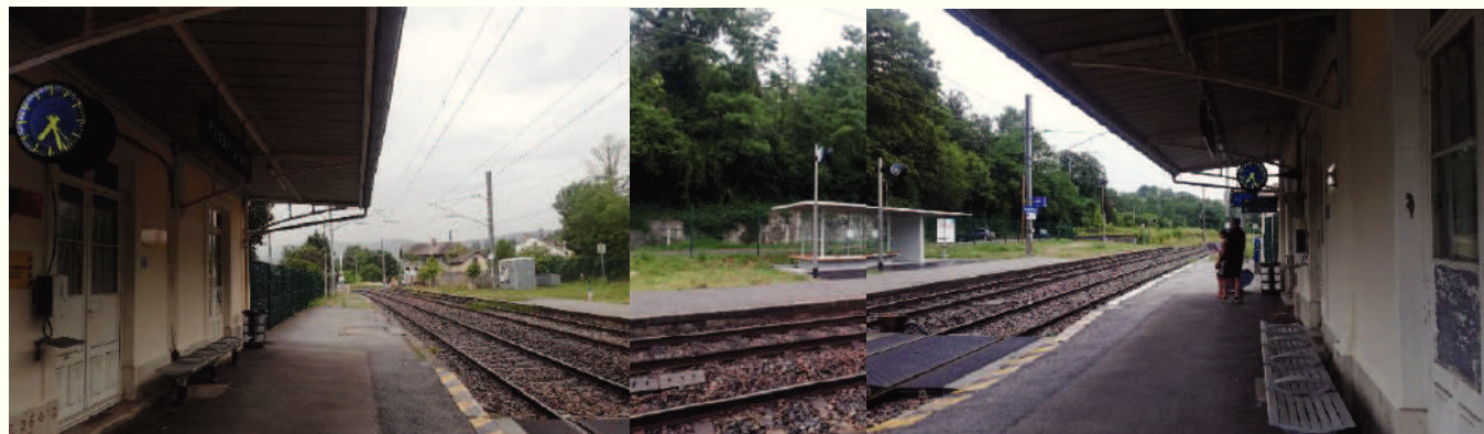
^Quais avec passage piétons à niveau
