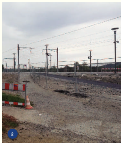
^chemin d'accès quai nord en travaux
