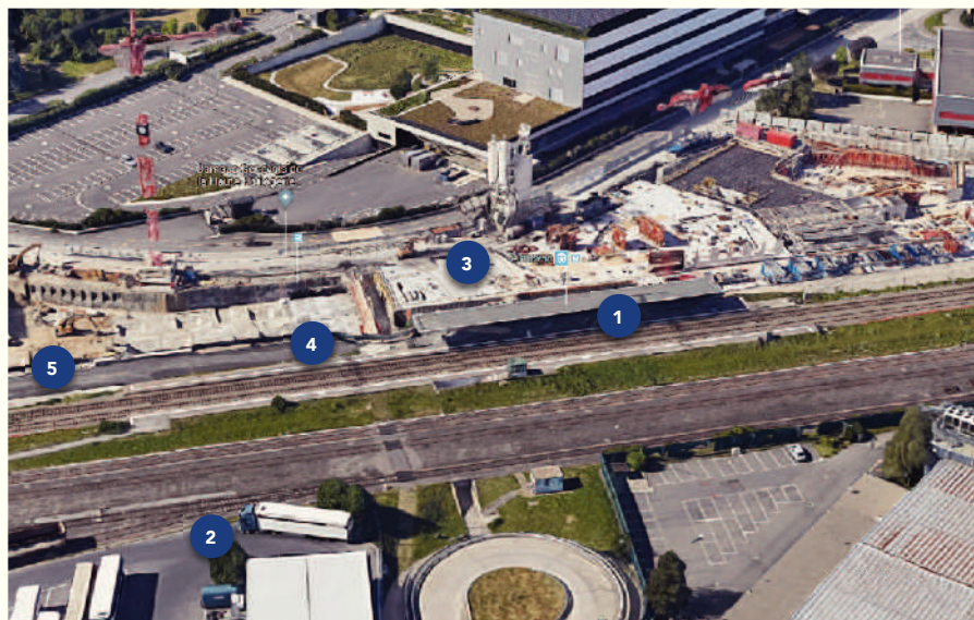
^Vue sur halte avant construction abri quai nord (cf photo 4)
