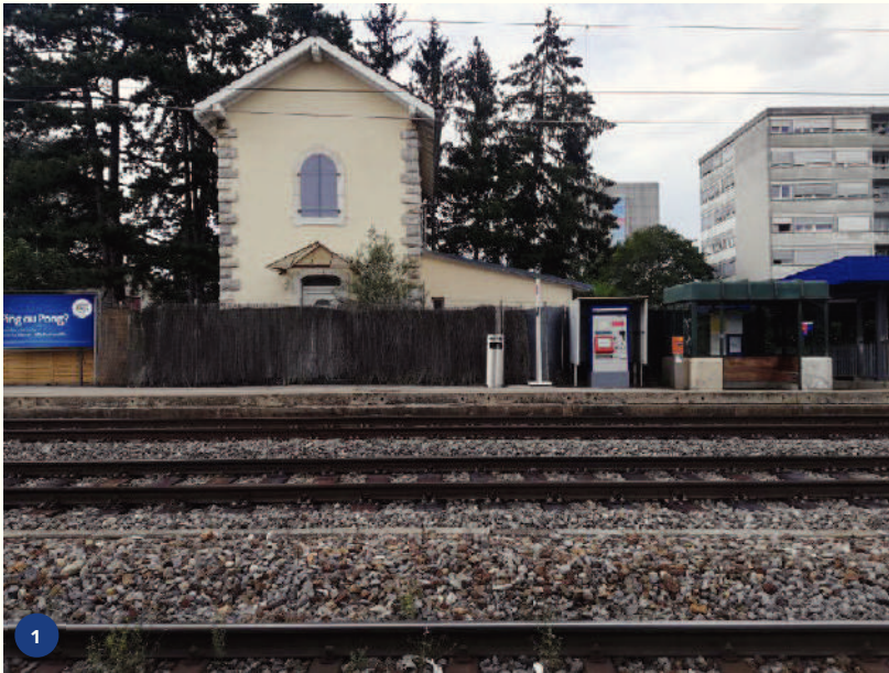
^Ancien bâtiment de halte privatisé et équipements de quai
