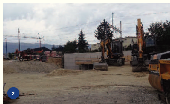
^Aménagement d'un passage souterrain (en cours)
