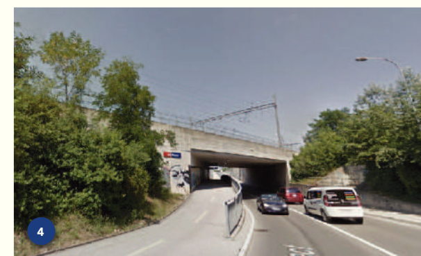
^Accès actuel sous voies le long de la route (4, 5)
