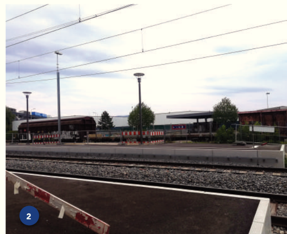
^Vue sur quai sud en travaux
