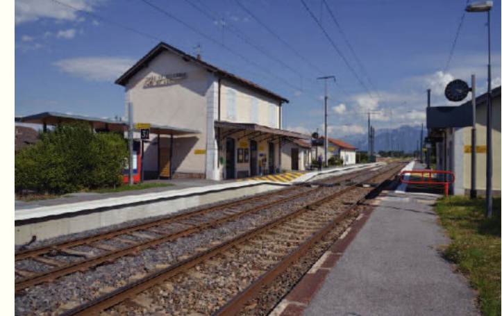
^ Gare 2 quais ; traversée à niveau
