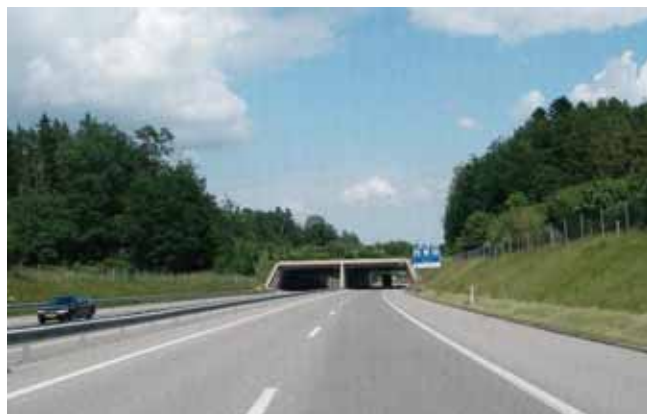
Passage à faune sur l'autoroute A1 Yverdon - Morat près d'Estavayer - le - Lac (CH).
