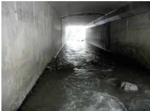
L'ouvrage hydraulique sous l'A40, pour le passage du Bronze, ne dispose pas de banquettes pieds secs.
